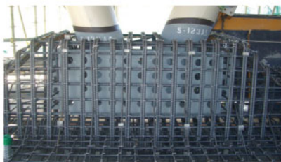
格点部の配筋状況
