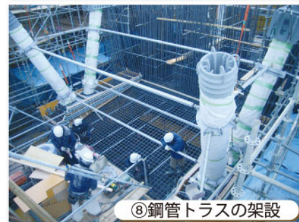
⑦ 鋼管トラスの架設
