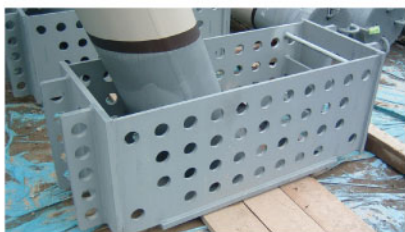
格点構造（改良鋼製ボックス方式）
