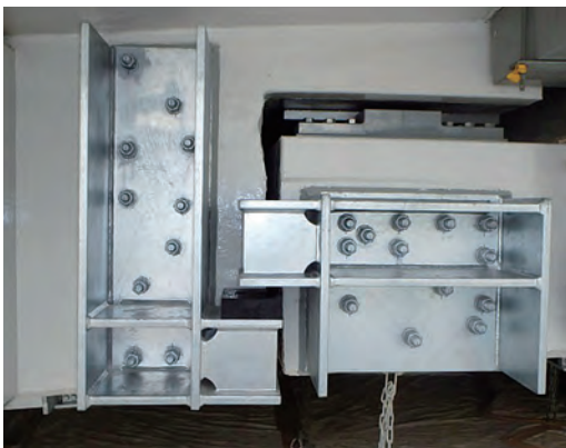
写真 22 浮き上がり防止構造
