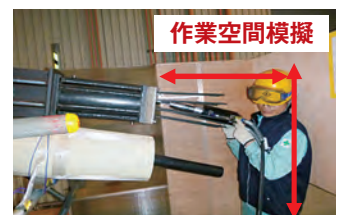
写真 12 作業空間確認状況
