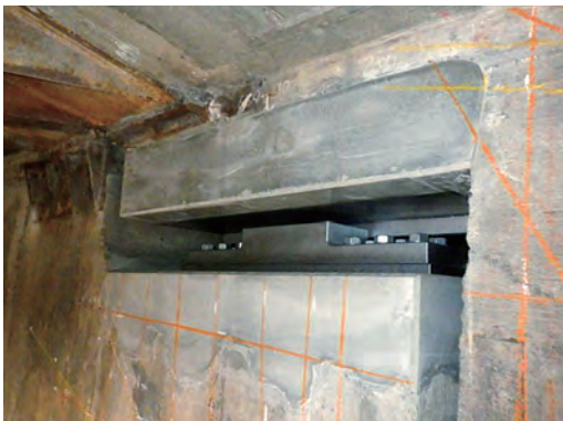
写真 21 新設支承設置完了
