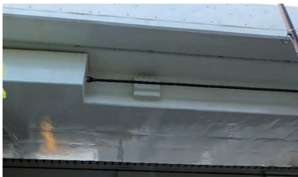
写真 16 外ケーブル配置完了
