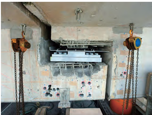
写真 20 新設支承設置状況
