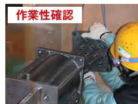
写真 11 支圧板取付け状況
