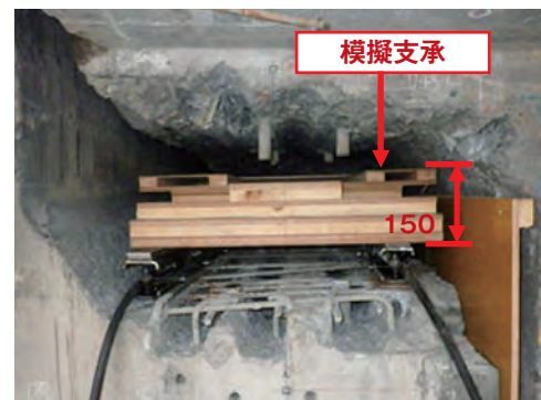
写真 17 新設支承施工試験状況
