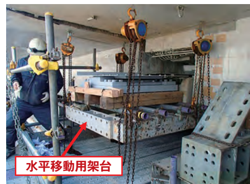
写真 18 新設支承架設状況
