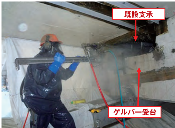
写真 13 ゲルバー受台はつり状況
