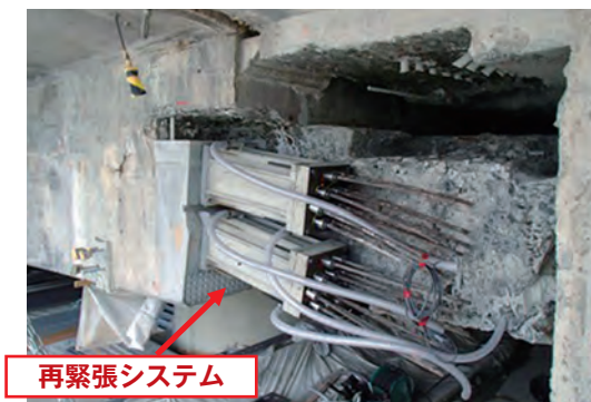
写真 15 再緊張システム配置状況
