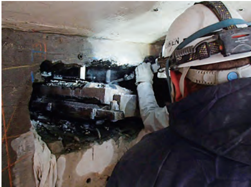
写真 19 既設支承撤去状況
