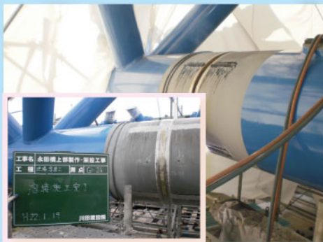
②現場溶接
