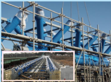
①クレーン架設&トラス部材架設完了
