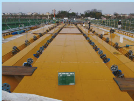
④床版型枠組立
