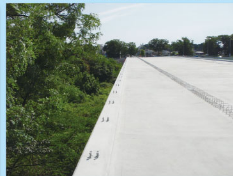
⑫橋面工・地覆完了
