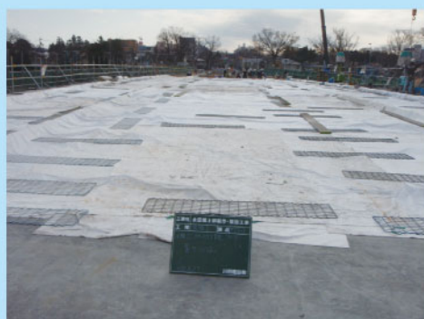
⑦床版コンクリート養生
