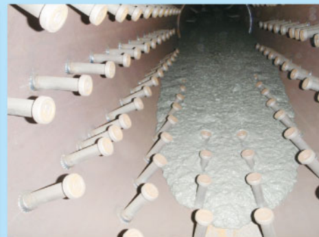
③斜材上床版定着部 中詰めコンクリート打設状況
