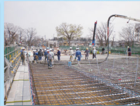
⑥床版コンクリート打設状況
