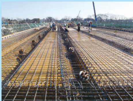
⑤床版下筋組立
