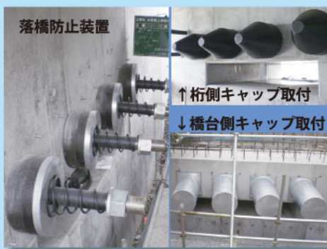
⑪落橋防止装置
