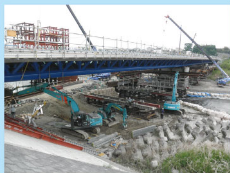
⑩支柱式支保工解体
