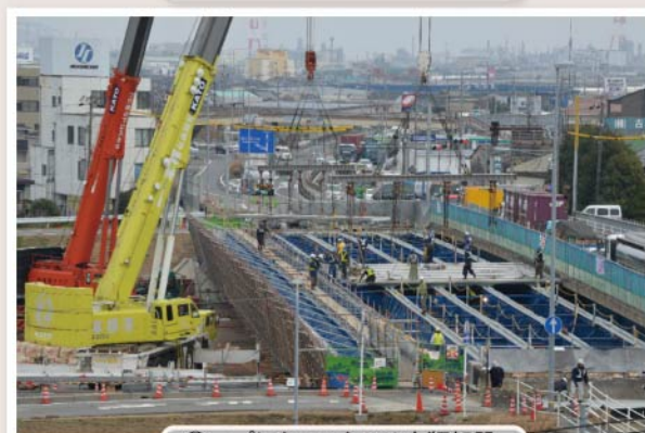
③ プレキャストPC床版架設
