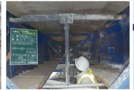
切断水の養生・回収
