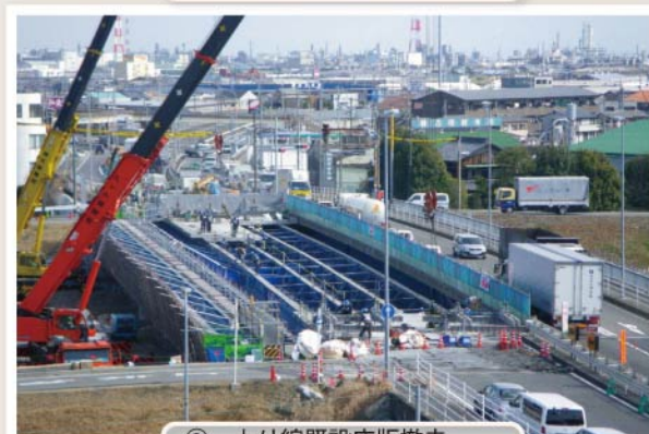
② 上り線既設床版撤去
