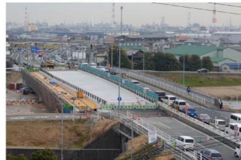
上り線床版施工完了
