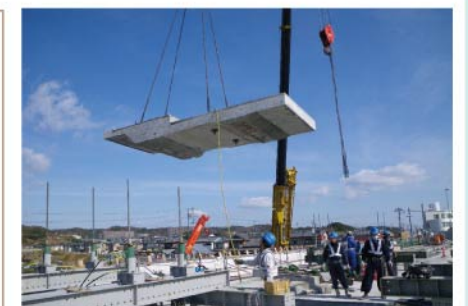
撤去・運搬・処理
