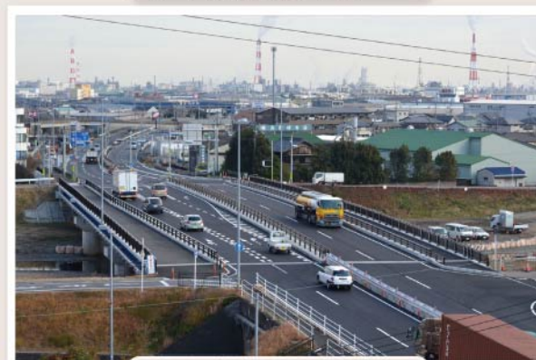
⑦ 工事完了
