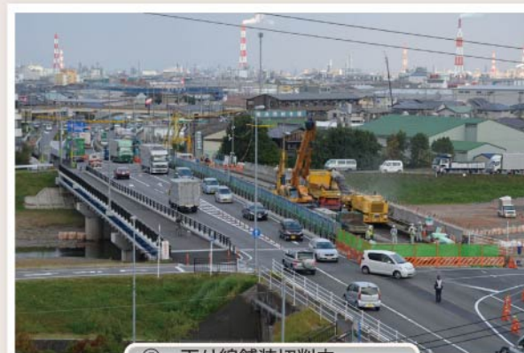
⑤ 下り線舗装切削中
