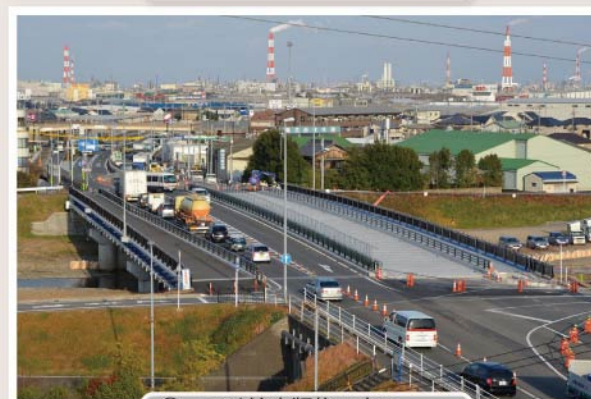
⑥ 下り線床版施工完了
