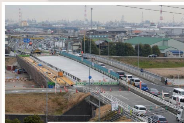
④ 上り線床版施工完了
