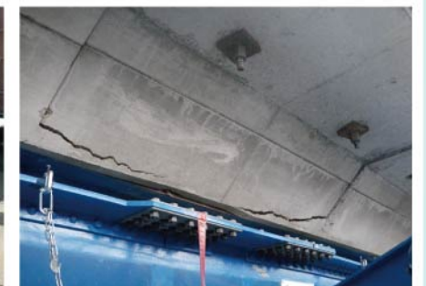
ジャッキアップ
