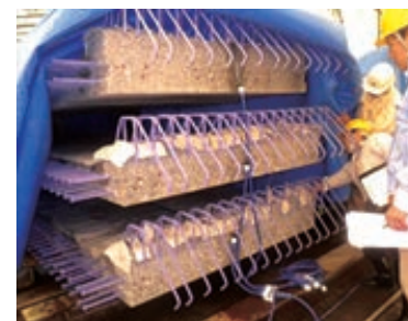
湿潤養生状況
