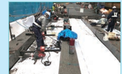
鋼桁上床版に水平コア削孔
