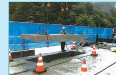
中間床版の切断・撤去
