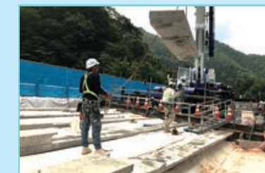
鋼桁上床版の撤去
