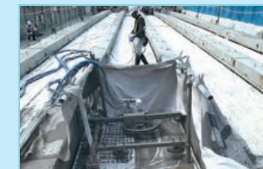
ワイヤーソーで水平切断
