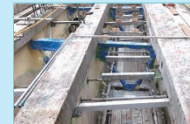
横倒れ補強・床版仮受の配置状況
