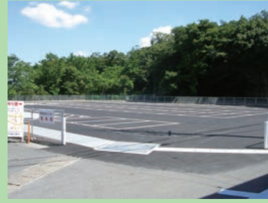
赤坂雨水調整池 (駐車場)
