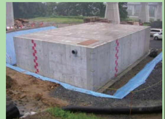
圏央道川口トンネル北貯留槽
