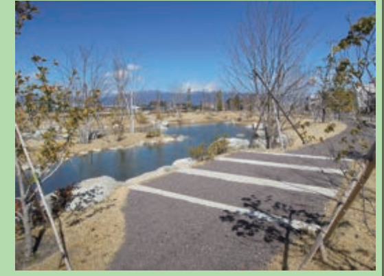
常永 2 号貯水槽 (ビオトープ)
