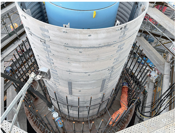
橋脚①と橋梁桁床版に適用されたKKフォーム
