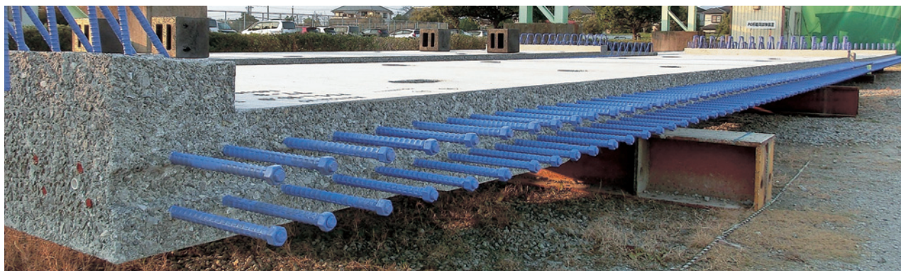
写真 1 合理化継手を使用したプレキャスト PC 床版
