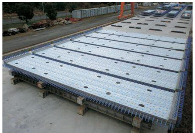
写真6 平坦性確認試験
