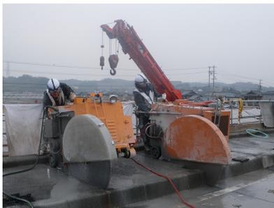
大型ブレードによる切断
